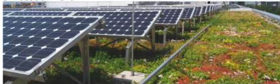
Abb. 130: PV-Auflastanlage mit extensiver Dachbegrünung (Foto: ZinCo GmbH )
