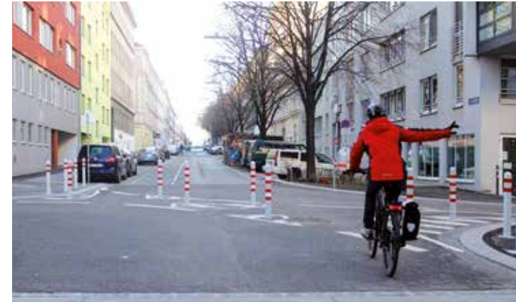
Abb. 35: Diagonalsperre in Wien – Goldschlagstraße # Hackengasse (rechts) 22
