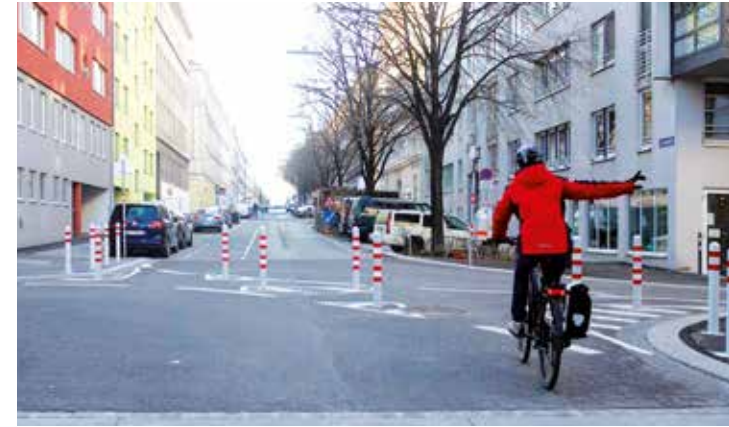
Abb. 37: Diagonalsperre in Wien – Goldschlagstraße # Hackengasse 22
