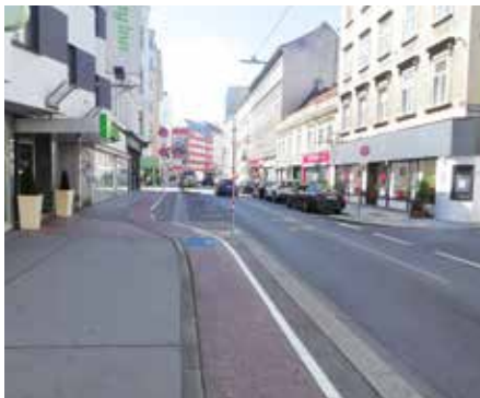
Abb. 20: Margaretenstraße (bei Hausnummer 53)
